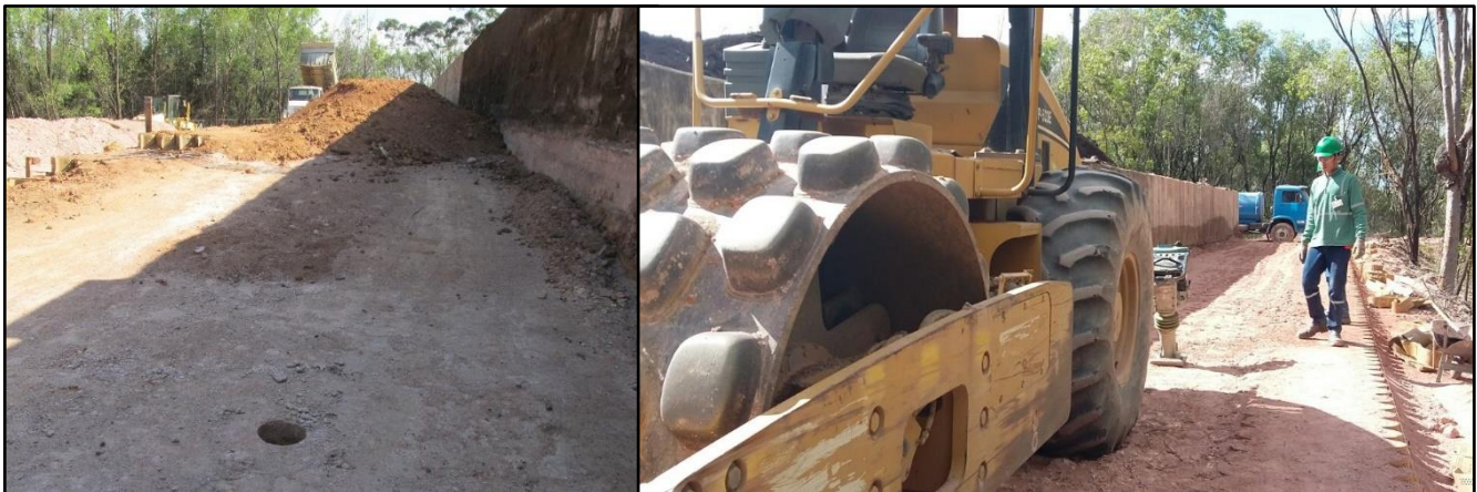
Figura 4. (a) Ensaio de compactação na fundação (b) Equipamentos utilizados para a compactação.
