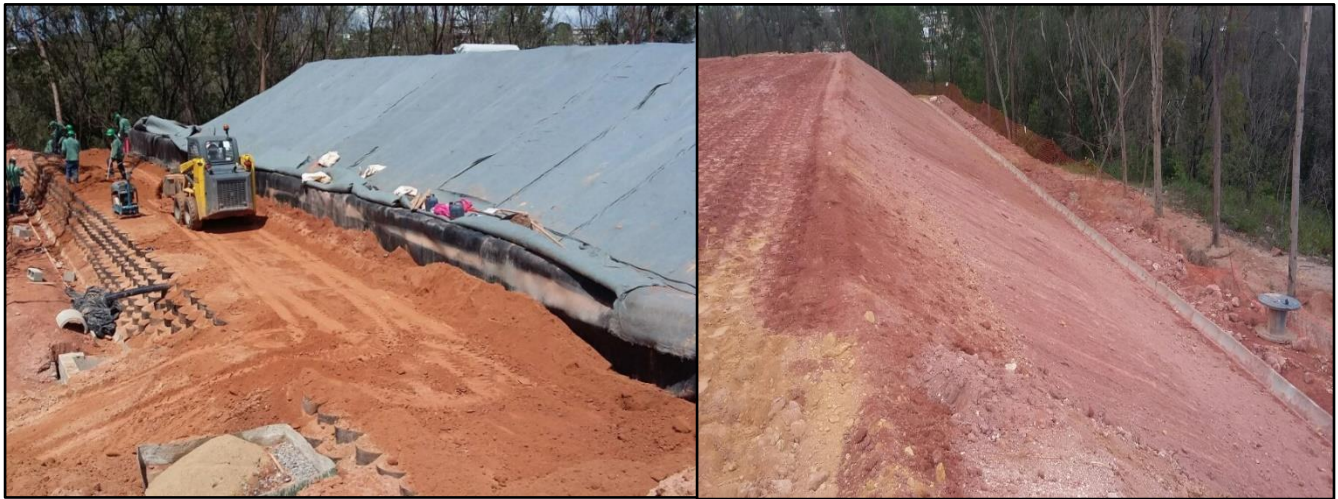
Figura 9. (a) Camada de geocomposto drenante instalada (b) Solo de cobertura já instalado.
