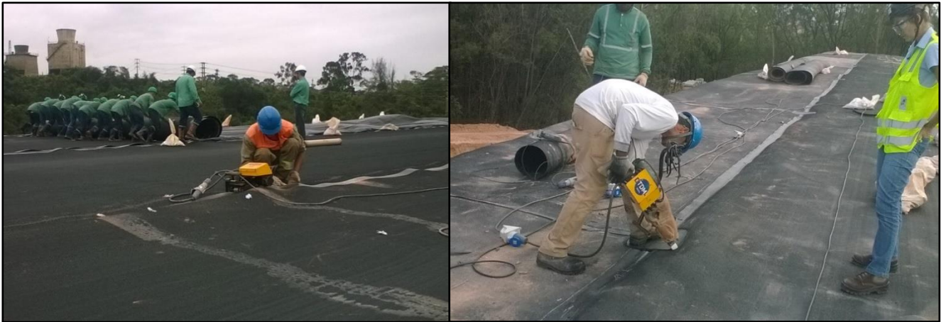
Figura 7. Processo de instalação da geomembrana sobre o aterro.
