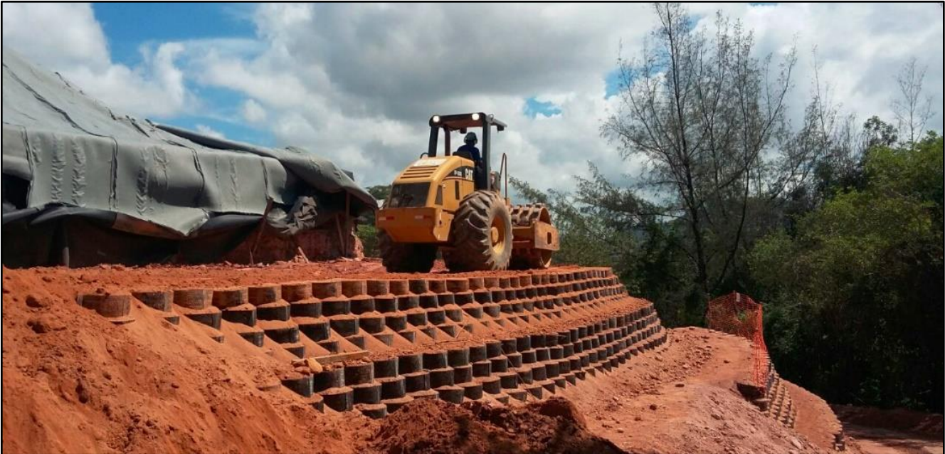
Figura 5. Construção do muro com face em geocélulas preenchidas com solo.
