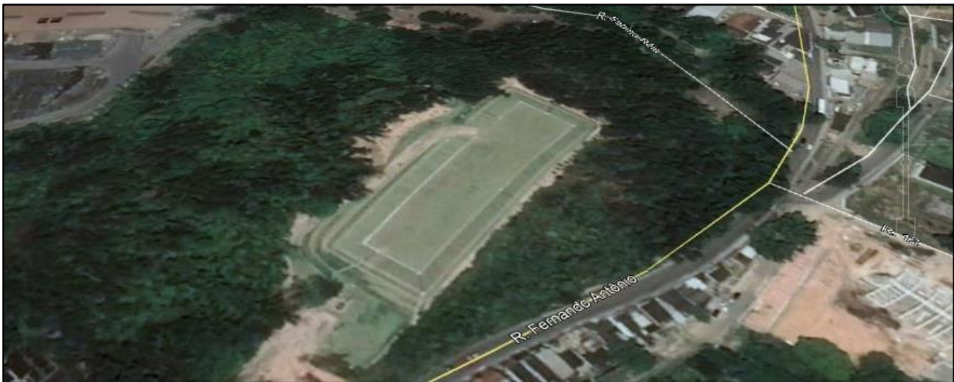
Figura 12. Obra finalizada (Fonte: Google Earth)
