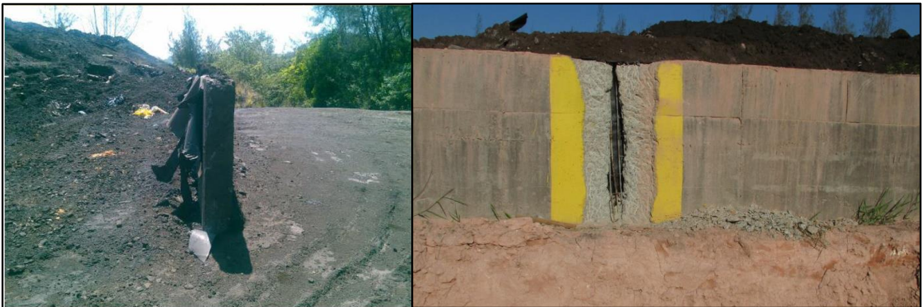
Figura 2. Muro de concreto reforçado perimetral existente.
