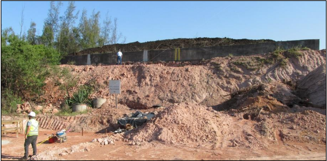
Figura 3. Situação da obra após retirada da vegetação.
