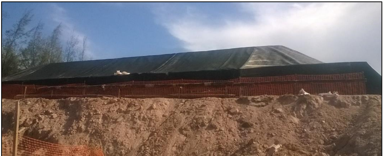
Figura 8. Aterro completamente fechado e impermeabilizado
