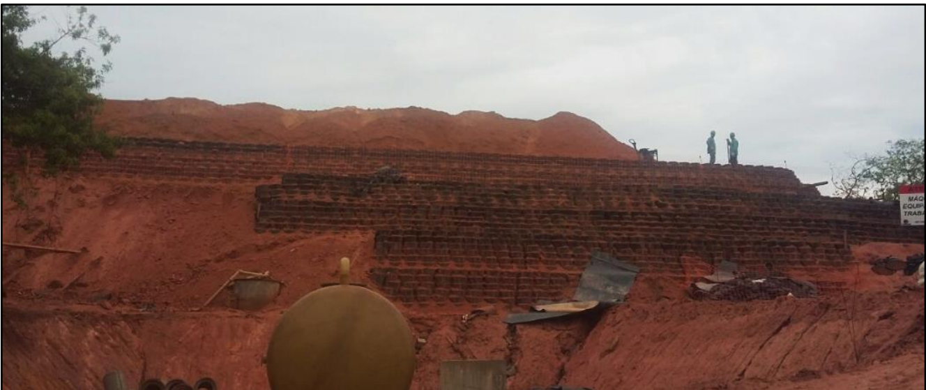
Figura 6. Vista panorâmica do processo construtivo do muro perimetral.
