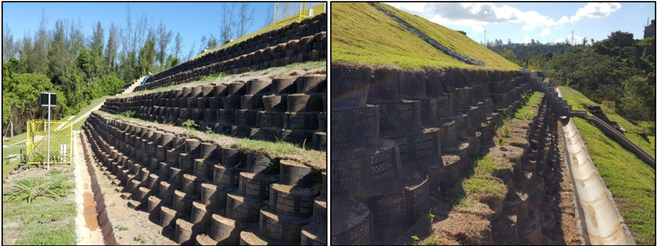
Figura 11. (a) Face em geocélulas (b) Saída do sistema de drenagem com geotubos
