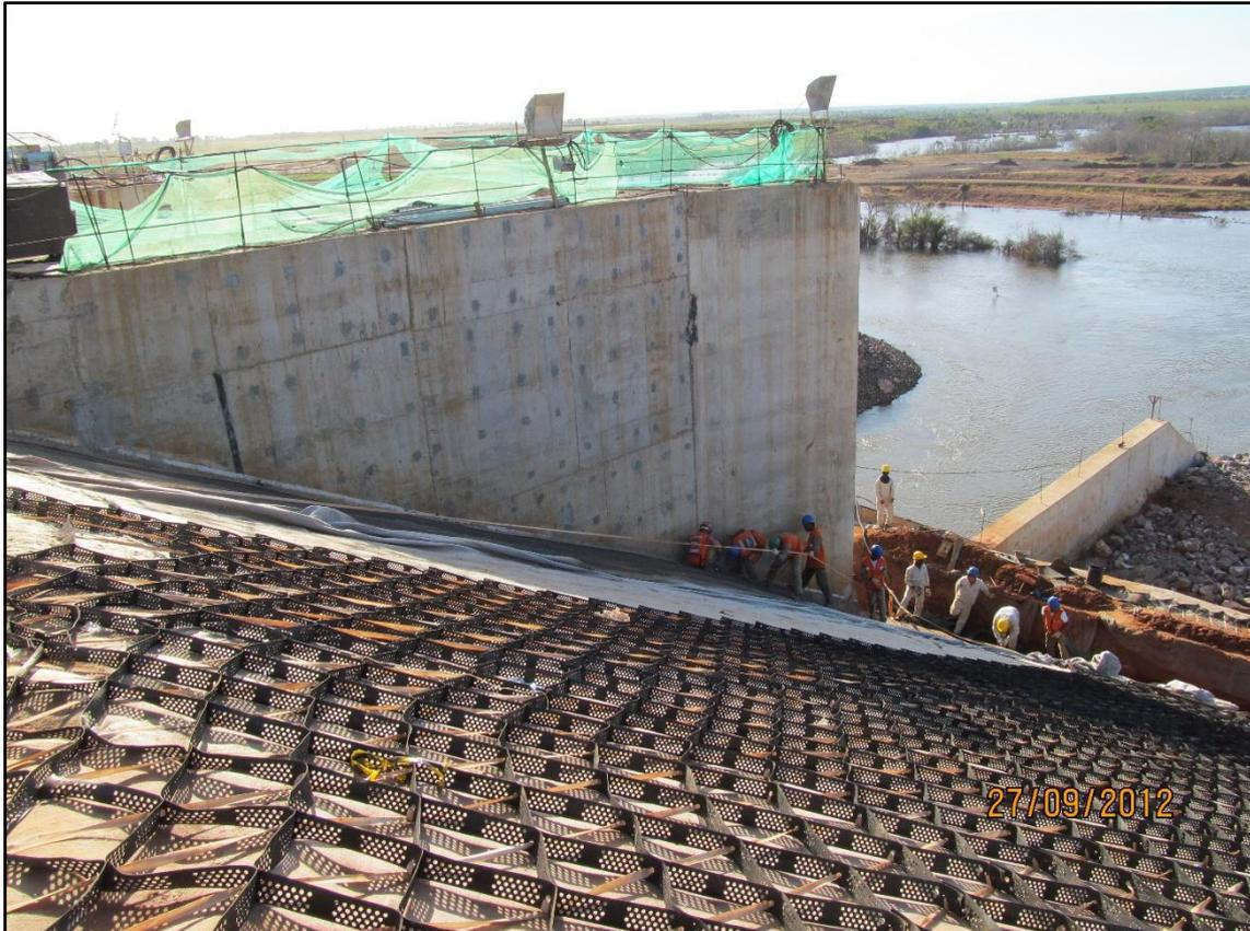
**Figura 5.** Instalação das geocélulas PEAD ao lado das comportas de concreto.
