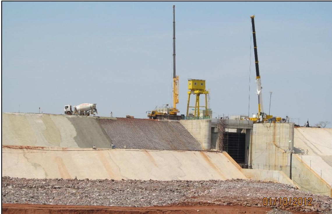
**Figura 7.** Panorâmica da colocação do concreto nas geocélulas de PEAD.
