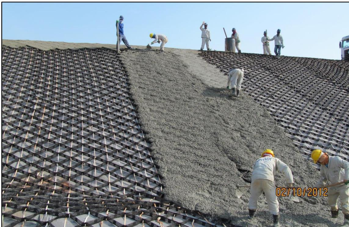
**Figura 6.** Colocação do concreto dentro das geocélulas de PEAD.
