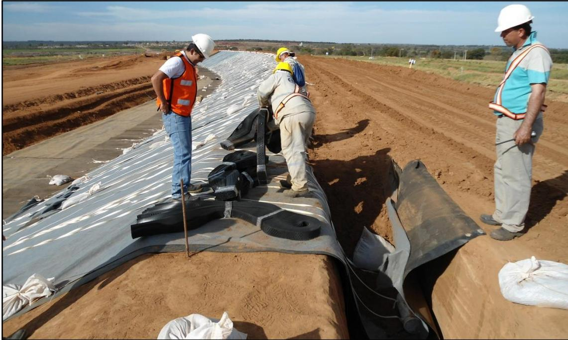
**Figura 3.** Início do processo de instalação onde pode se ver a ancoragem superior das geocélulas e cintas de PET, assim como a geomembrana protegida com geotêxtil.
