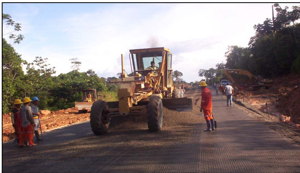
FOTO 5: Instalação da base granular sobre a geogrelha tipo 2.
