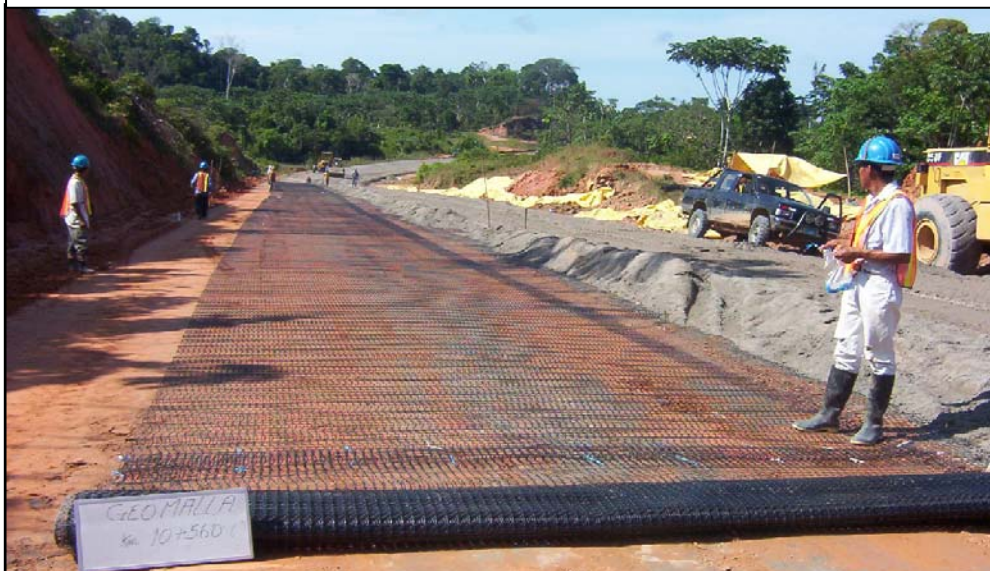
FOTO 3: Instalação da geogrelha tipo 1 e a camada de areia de rio.
