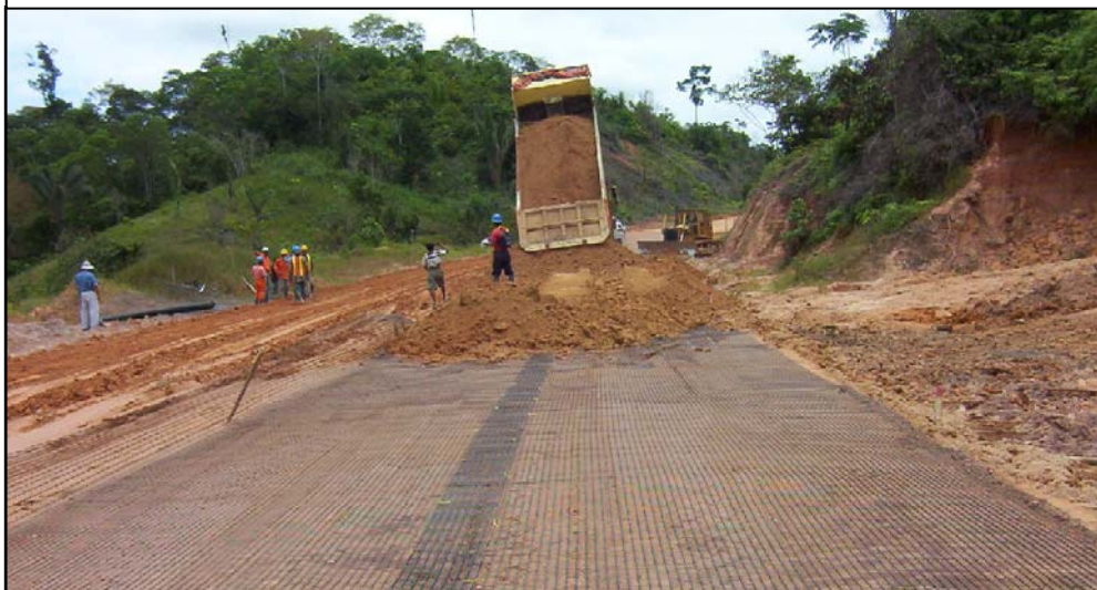
FOTO 4: Instalação da sub-base conformada por areia siltosa
