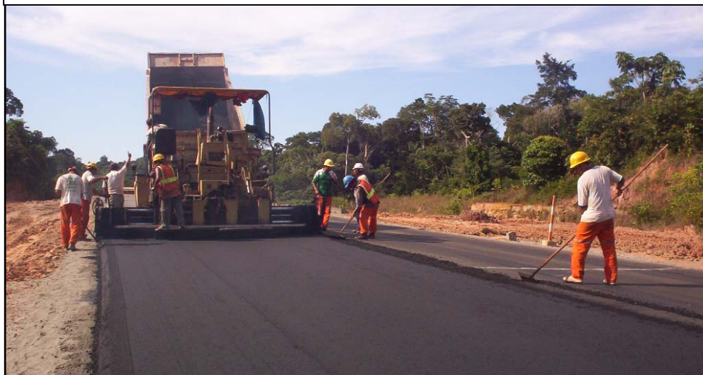
FOTO 6: Aplicação da camada de asfalto quente (maio de 2005).
