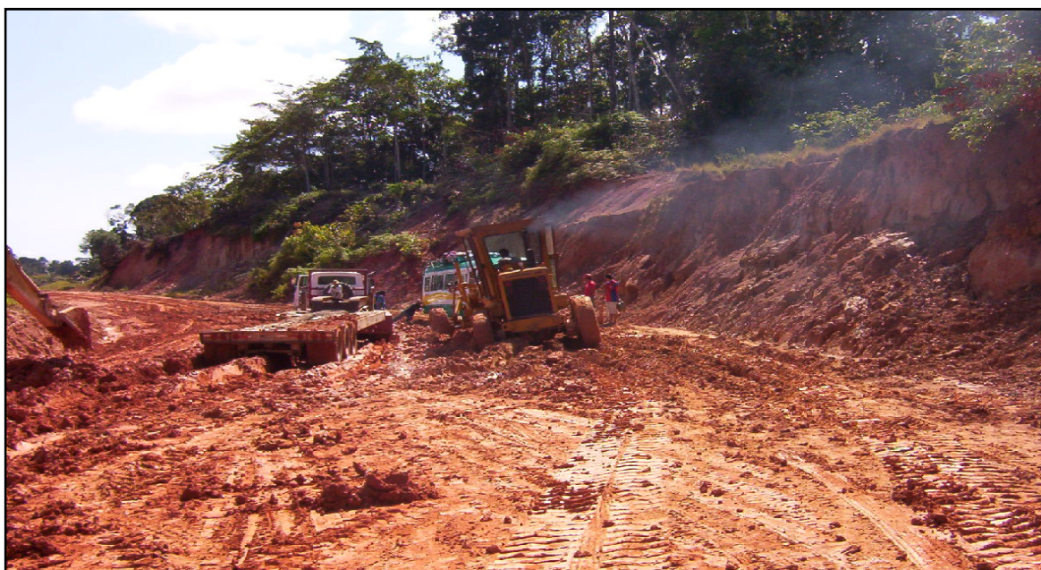
FOTO 1: Subleito mole conformado por argila saturada.
