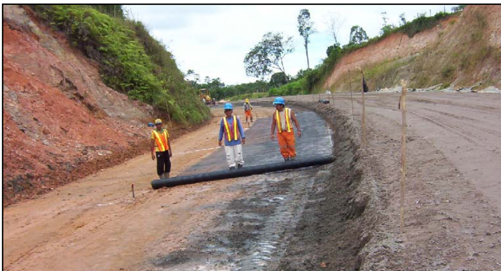
FOTO 2: Instalação da geogrelha bidirecional rígida tipo 1.
