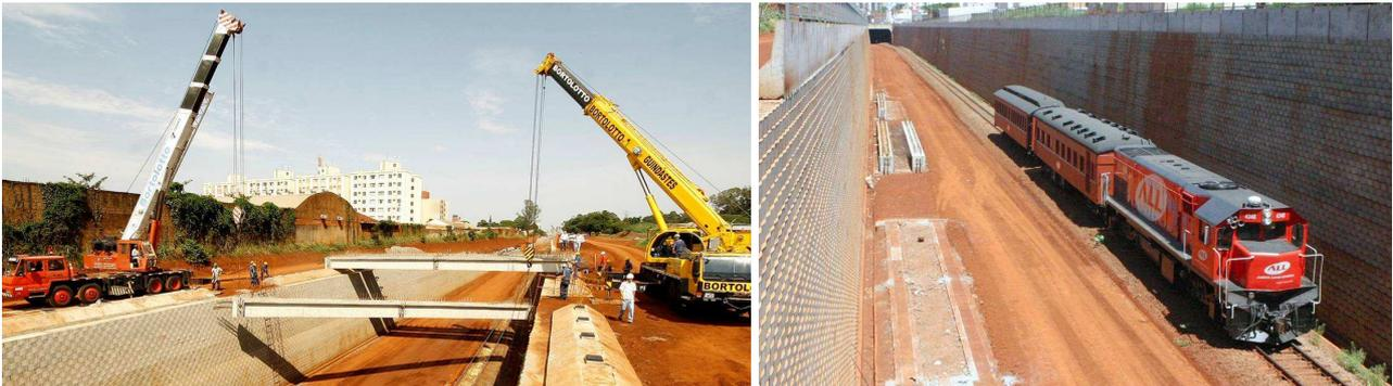
Figuras 8 e 9 – Lançamento das vigas dos viadutos e foto da obra finalizada.
