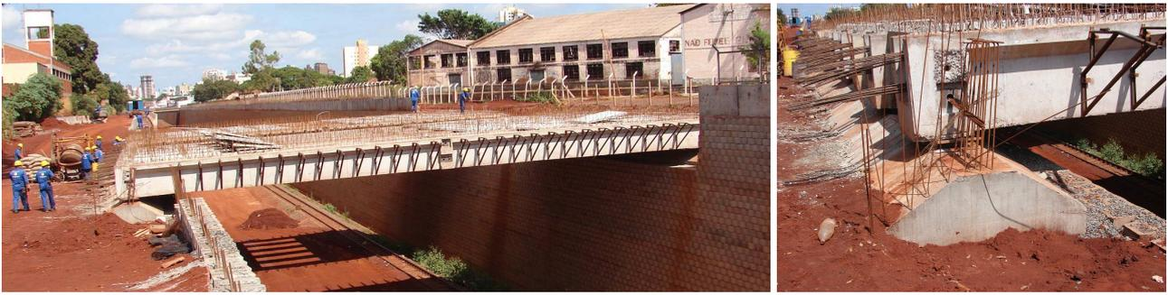
Figuras 6 e 7 – Vista dos viadutos e detalhe do apoio sobre o muro em solo reforçado.
