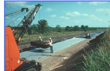
**Filtração:** O fluxo de água do subleito para a camada granular pode carregar finos do subleito. Isso pode ocorrer por causa do aumento do nível de tensões no subleito devido à passagem dos trens. Neste caso, um geotêxtil pode atuar como filtro, permitindo a livre passagem da água e ao mesmo tempo retendo as partículas sólidas do subleito. Para desempenhar essa função, o geotêxtil deve atender a critérios específicos de permeabilidade e filtro, além de ser resistente à colmatção.
