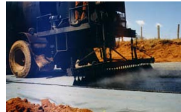
Geossintético em recapeamento (**)
