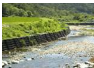
Vista final do talude
