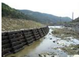
Construção com blocos de polietileno (PE)
