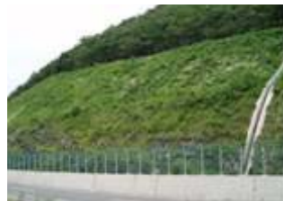
Vista final do talude
