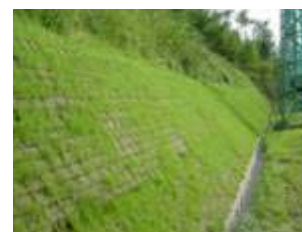
Vista final do talude
