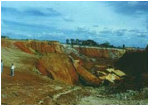
Danos provocados por erosão
