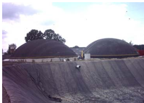
Digestores anaeróbicos para lagoa de resíduos
