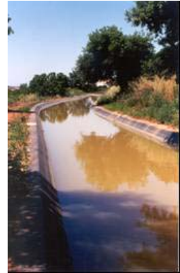
Canal de irrigação
