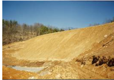
Aterro reforçado concluído
