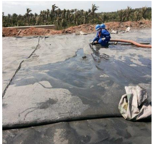
Figura 3 (b) – Teste em campo do preenchimento das geoformas.
