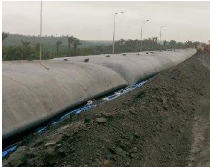
Figura 5 – Camada inferior de geoformas.
