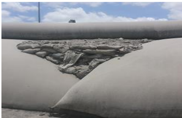
Figura 7 – Preenchimento dos vazios entre geoformas.
