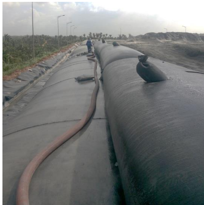
Figura 6 – Camadas inferior e superior de geoformas.
